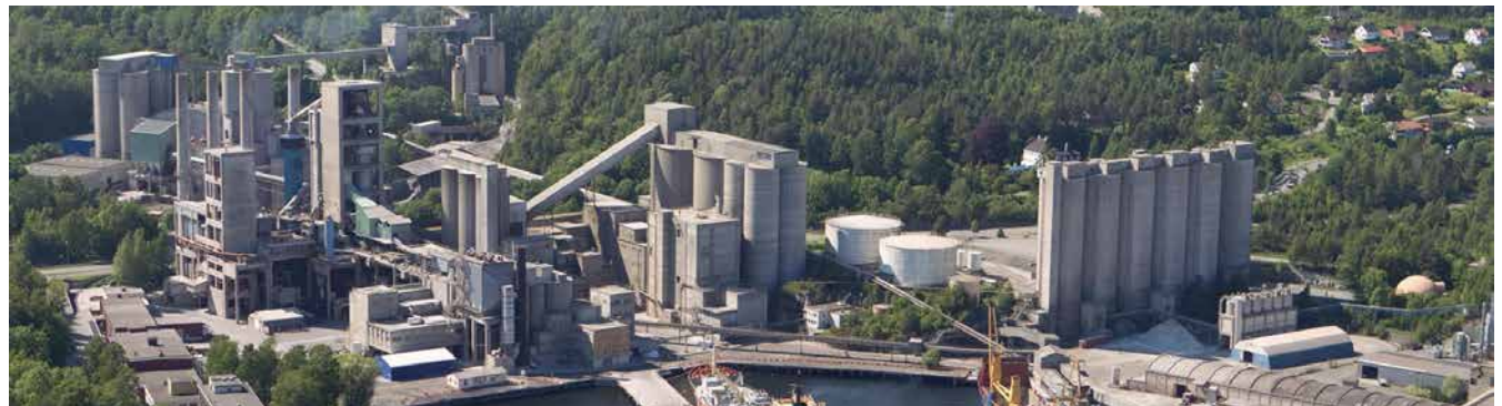
Weltweit erste großtechnische CO 2 -Abscheideanlage der Zementindustrie in Brevik (Norwegen)
