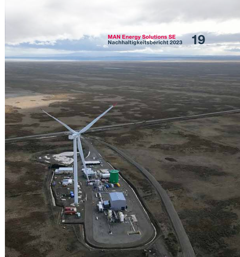
Pilotanlage zur Herstellung von e-Fuels in Punta Arenas (Chile)
