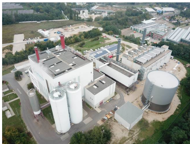
MAN Energy Solutions hat das neue Gasmotorenkraftwerk der Stadtwerke Frankfurt (Oder) in Betrieb genommen ©Stadtwerke Frankfurt (Oder)
