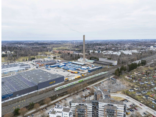
Die MAN-Großwärmepumpe wird jährlich 200 GWh Wärme an rund 30'000 Haushalte in Helsinki liefern und die CO 2 -Emissionen um 26'000 Tonnen reduzieren. (© Helen Oy)
