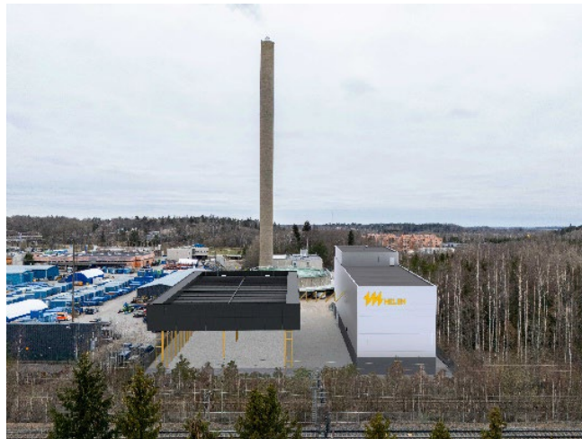
Das künftige Fernheizwerk Patola in Helsinki wird die weltweit größte Luft-Wasser-Wärmepumpe beherbergen (© Helen Oy)
