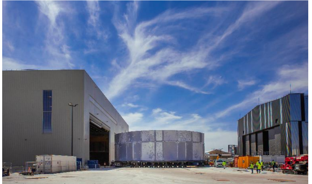
Der ‚Upper Cylinder‘ verlässt die Vormontagehalle auf der ITER-Baustelle in Cadarache, Südfrankreich.
